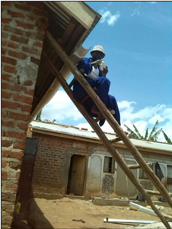
De dakgoten worden bevestigd en aangesloten op de watertank.....
