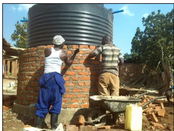
...en de tank wordt ingemetseld...
